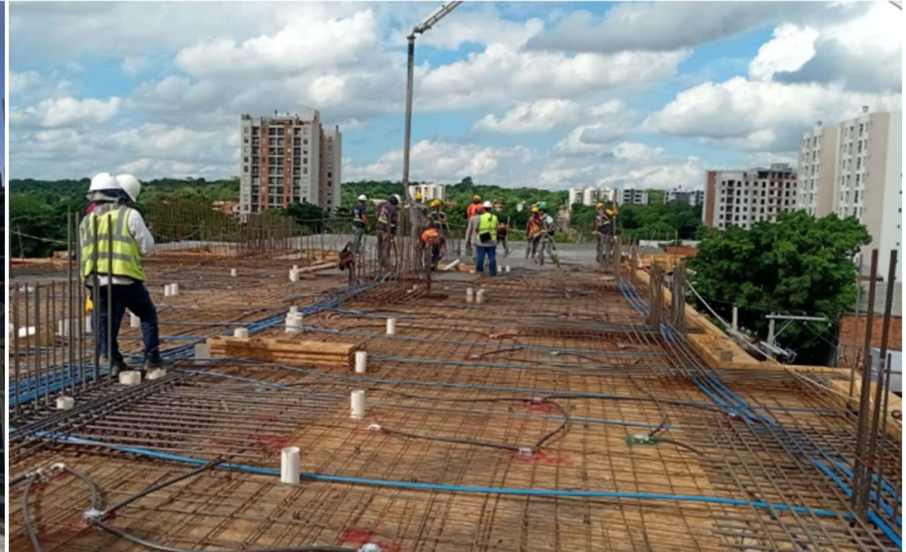
Cargamento de pilares N3-N4 – Cargamento de losa N3
